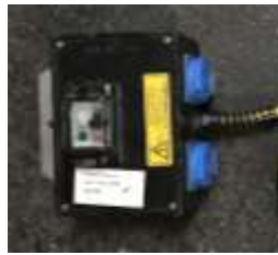
Prise T13 CH monophasé (charge admise: 10A, 230V, jusqu'à 2.3 kW) Steckdose T13 CH einphasig (zugelassene Leistung: 10A, 230V, bis 2.3 kW)
